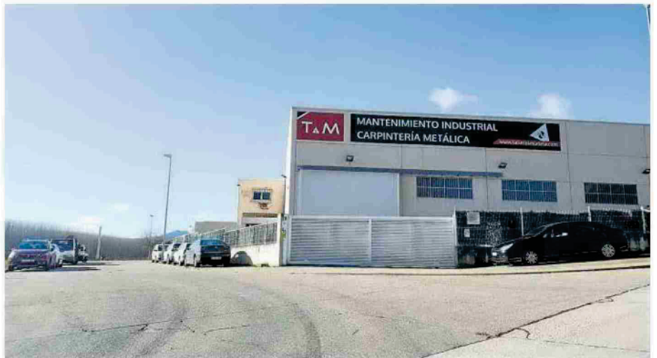
Una de las entradas de acceso al polígono industrial de Murieta desde la carretera de Vitoria Foto: Javier Arizaleta
