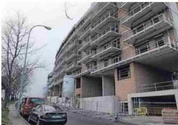
Aspecto del edificio ya sin obras en abril de 2022.
