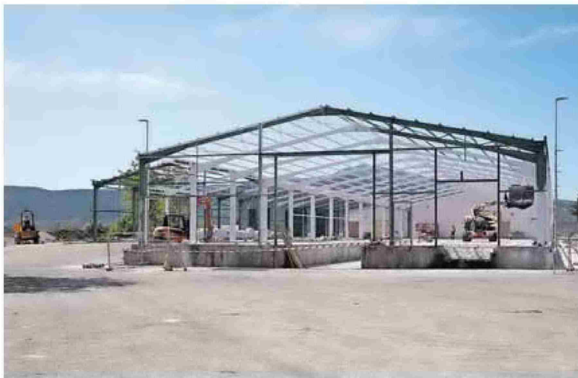
Obras ya en marcha en las instalaciones de la antigua empresa Solano de Aoiz, cerrada en 2007.
