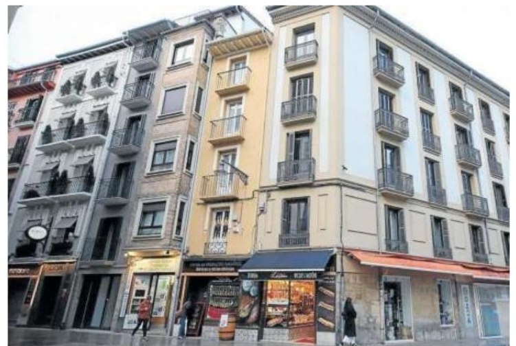
Con tejado más bajo y en color amarillo (2º por la d), fachada del edificio. Foto: Javier Bergasa
