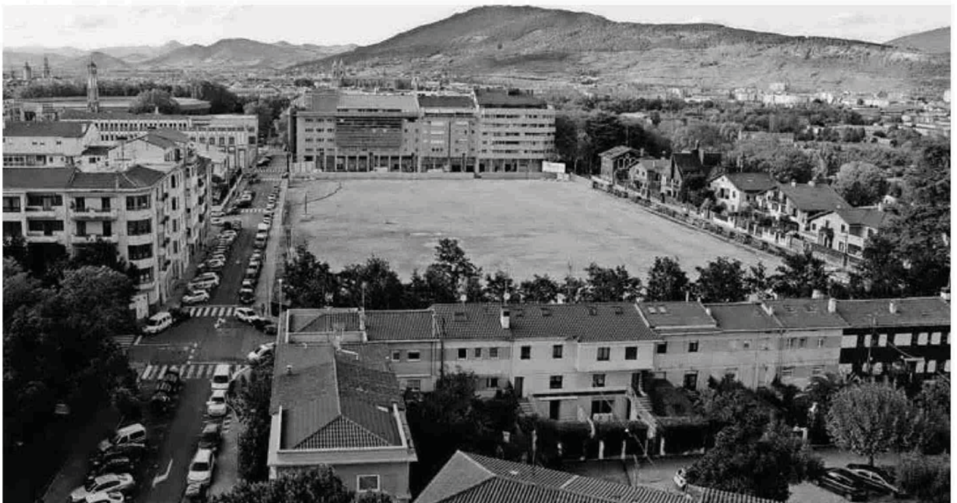
En pocas semanas comenzarán las obras de construcción de los primeros edificios en la parcela de Salesianos, y también las de urbanización.
