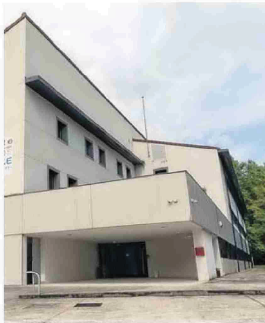
Edificio del CIL en el Campus Empresarial Lekaroz. A.D.C.
