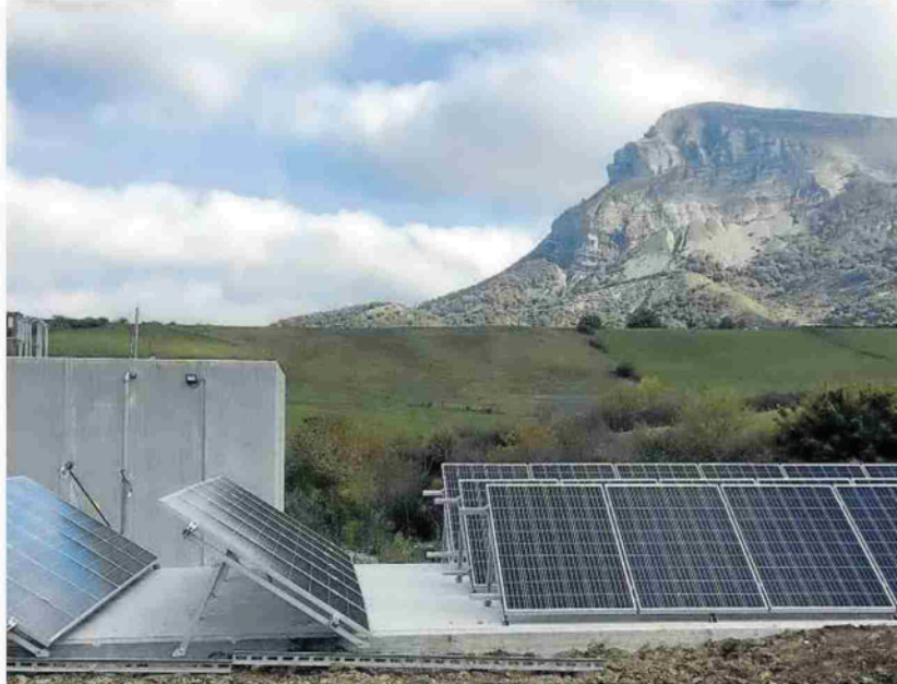
Instalación de placas fotovoltaicas. Foto: Nerea Mazkianun
