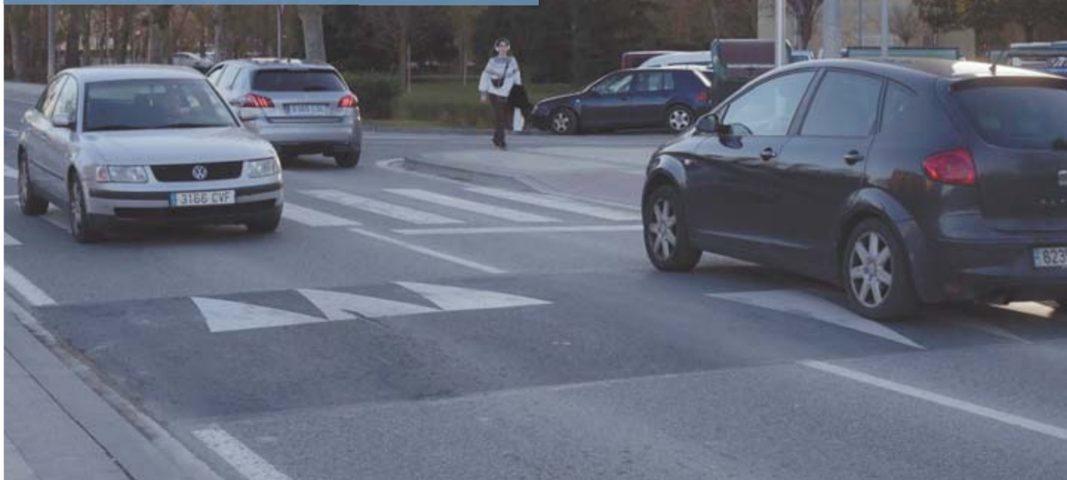
La elevación de calzada en la calle Sadar está colocada después del paso, por lo que no garantiza que los coches reduzcan la velocidad. GOÑI
