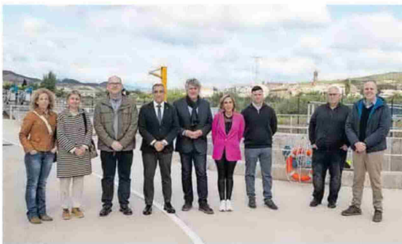
Autoridades presentes en la visita a la renovada depuradora de aguas residuales de Fitero. CEDIDA
