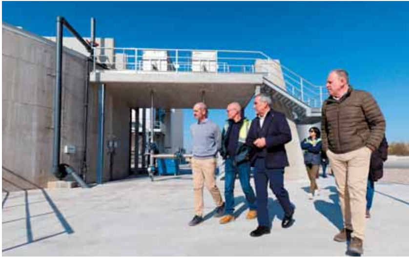
El consejero Chivite, junto a técnicos, en una visita a la depuradora de Tudela tras su reciente ampliación. CEDIDA
