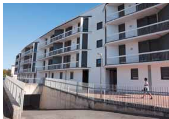
Imagen externa del bloque de viviendas de la calle Iturriburu. E.BUXENS
