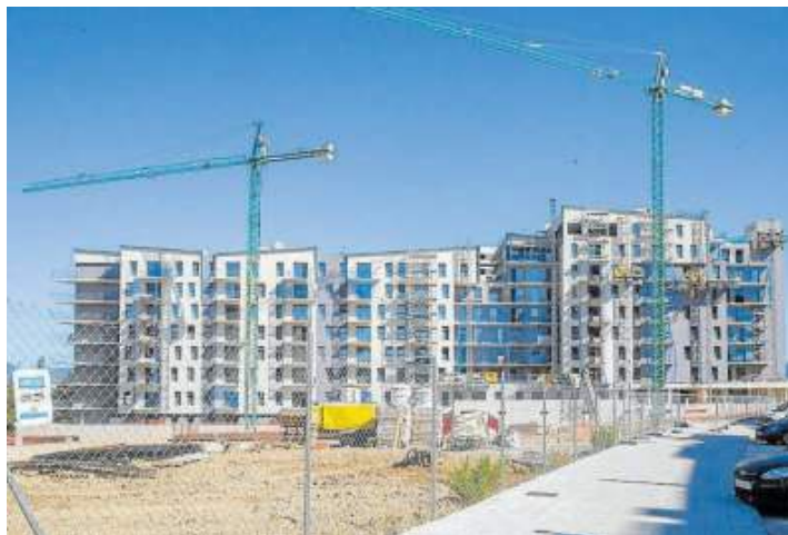
Viviendas en construcción en Barañáin. Foto: Patxi Cascante
