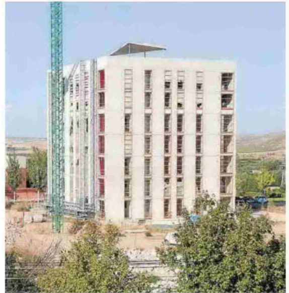
Vista del edificio con las obras abandonadas. Foto: F. P-N.
